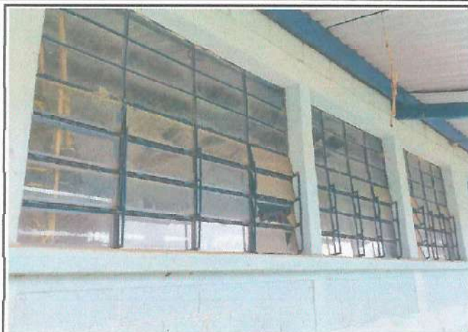
Foto 1: Reparación de vidrios de ventanería e instalación de balcones tipo barrote para mejorar seguridad.
