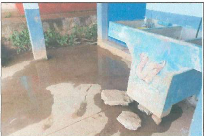
Foto 3: Mejoramiento y reparación de canales para bajada de agua pluvial
