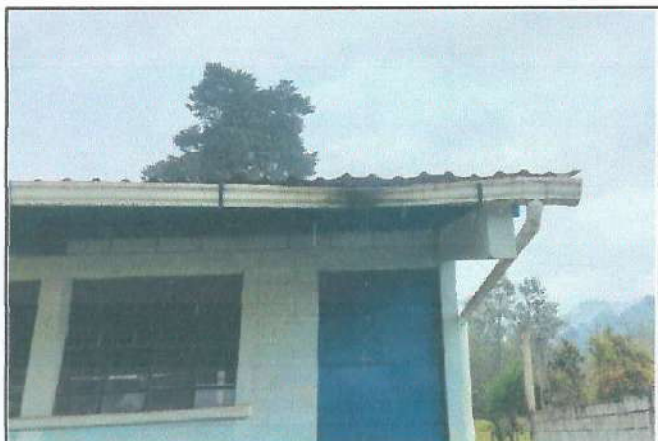
Foto 4: Mejoramiento y reparación de canales para bajada de agua pluvial
